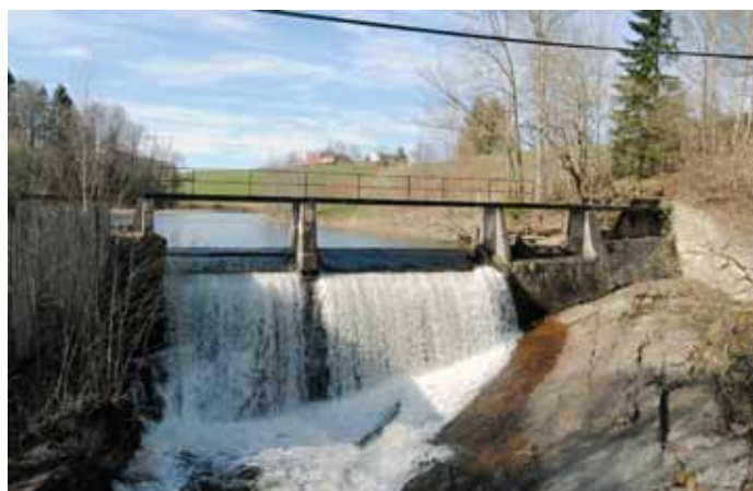
Kraftverkene forsynte bedriften med strøm. Her er fossen ved fabrikkens. Foto: Tone Sverreson Ørmen.
