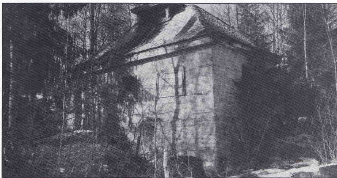
Kraftstasjonen ved "Mølsteddammen"
