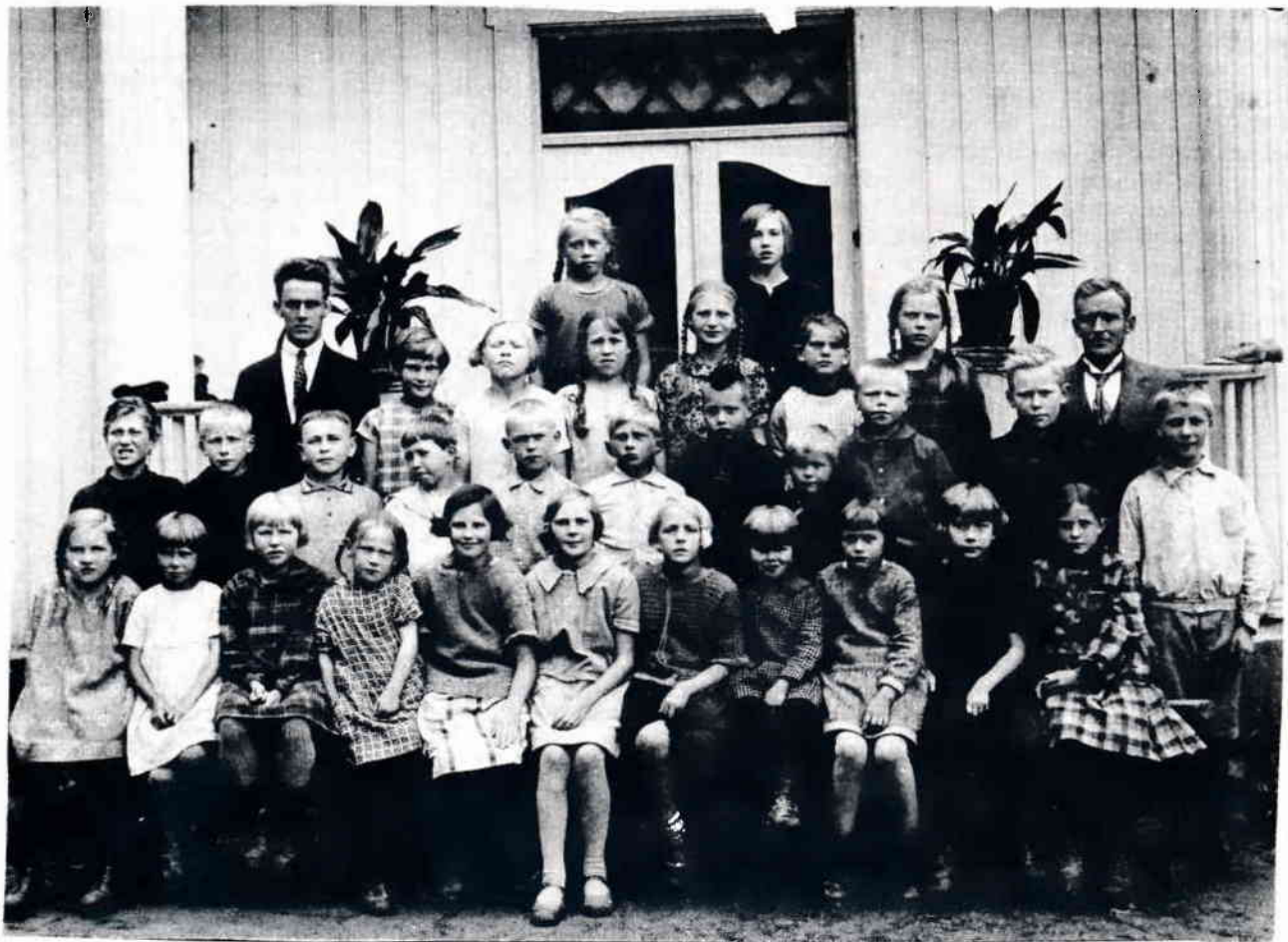
Elever fra Flåten og Skallestad ( leiet lokale) 1926
