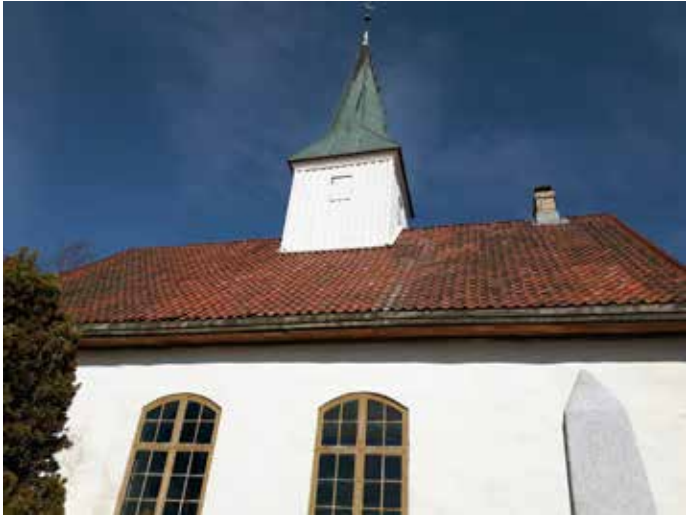
Takrytteren (tårnet) er fullrestaurert. Atter kan kirkeklokkene kime over Skogerbygda.
