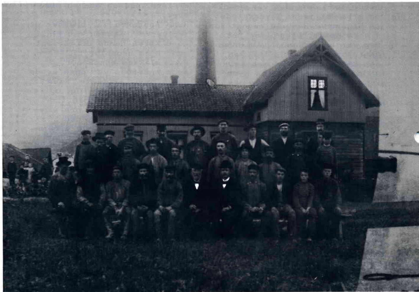
Arbeiderne på Stormoen Teglverk ca. 1906. Martin og Ivar Bjercknes i midten foran. Foto utlånt fra Skoger Historielag, fotokomite.
