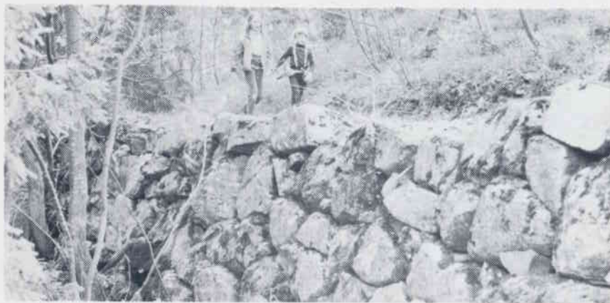
De som ferdes i områdene ved «Vaskeriet» kjenner sikkert denne solide veikanten igjen. Den er ikke bygd til gruvedriften, men anlagt av E-verket da man i begynnelsen av 1900 anla ny transformertorkiosk i Baklia.
