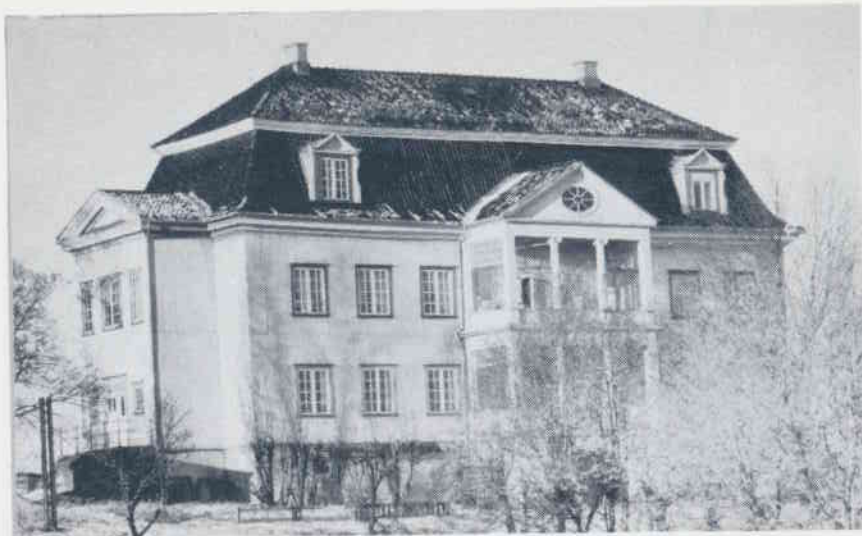
Søyleverandaen som ble revet i 1979, var utført med stildetaljer fra gresk byggekunst. Verandaen var meget sterkt råteskadet da den ble tatt ned. Foto: Jo. Sellæg, 1976
