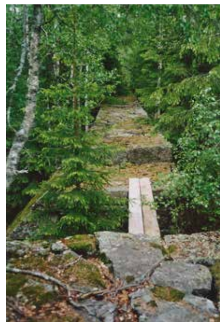
Bomannsdemningen 1998 ved Store Bergvann. To planker lager gangvei over luka. Foto: Erik Grinderud.
