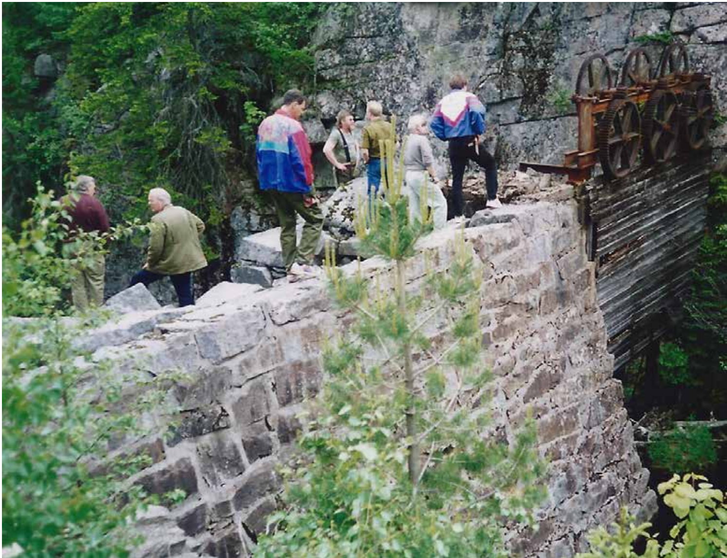
Befaring av Skoger Skogeierforening ved den høye utløpsdemningen ved Store Bergvann i 1998. Foto: Erik Grinderud.
