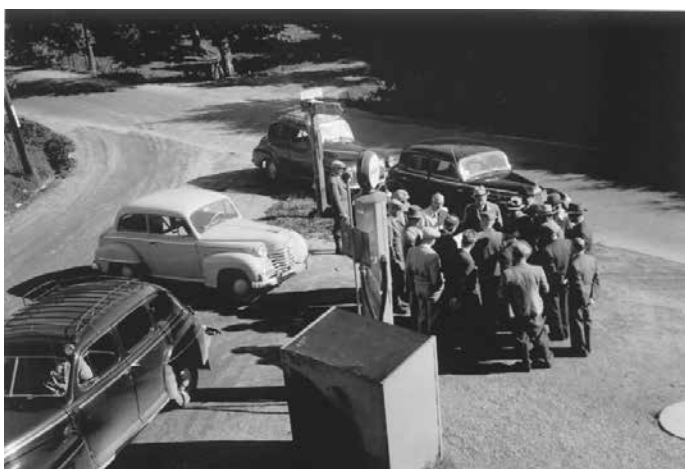
Befaring i Fagerheimkrysset Foto: Bjarne Eriksen
