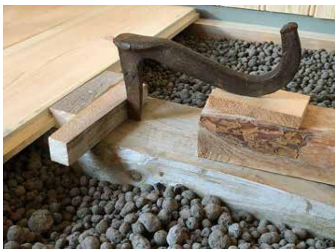
Bilde av gulvhake. Foto: Roald Rennmælmo.
