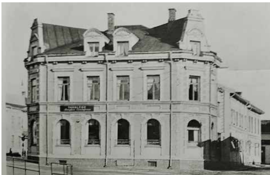
Skoger Sparebanks bygg fra 1898 til 1962.
