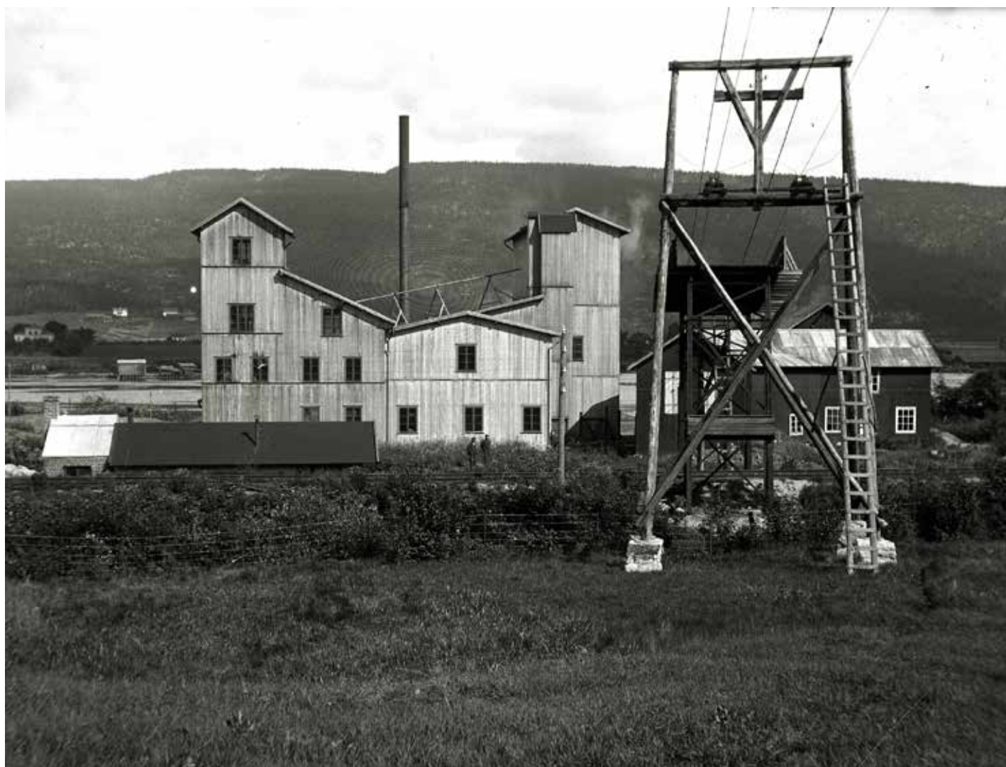
Det nederste taubanefeste ved knuse/vaskeanlegget på Pukerud.
